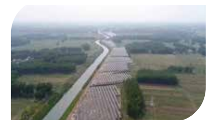
► 安徽临泉吕寨20MW光伏电站
