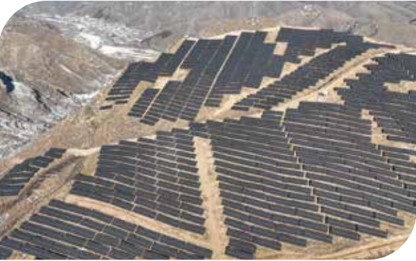
▶ 河北顺平台鱼乡100MW山地光伏项目
