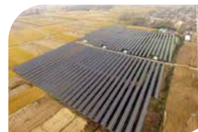
► 江苏泗洪孙园镇20MW光伏电站
